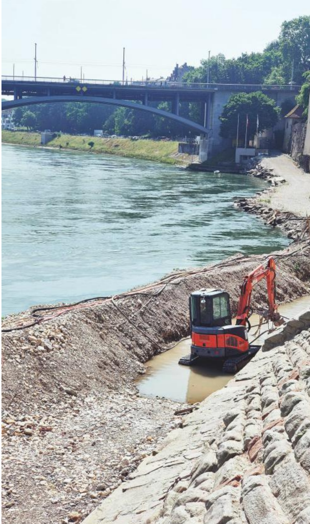
Die extra aufgeschüttete Baupiste zur Sanierung des Mauerfusses. Foto: © Dieter Bühler
