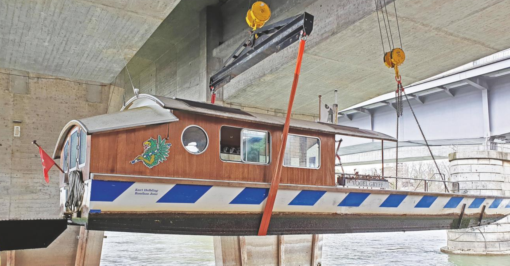
Nach fast 10 Betriebsjahren war es an der Zeit, die Klingental-Fähre musste das erste Mal seit Betriebsbeginn aus dem Wasser.
