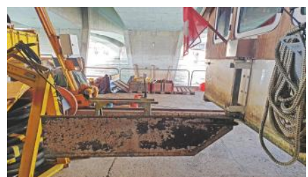
Die Ruderanlage, die seit einiger Zeit Spiel hatte, wurde demontiert und die Lager wurden ersetzt.
