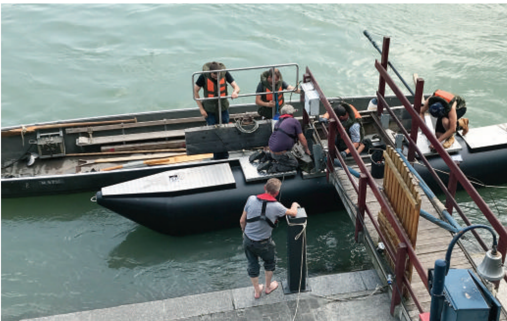
Montage des letzten neuen Schwimmers am Faehri-Steg beim Totentanz.
