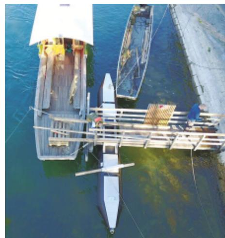
Montage des neuen Schwimmers beim Kleinbasler Steg der Münsterfähre
