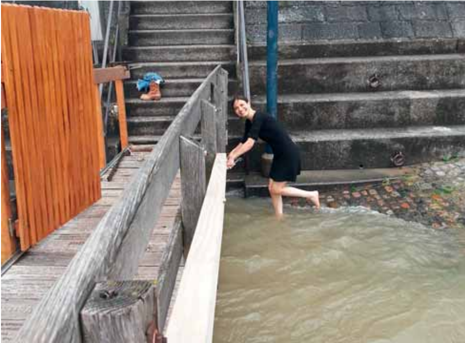
Helferin bei der Montage und ...
