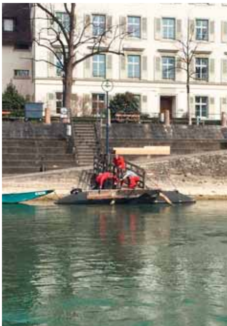
Austausch des Anfahrbalkens am Kleinbasler Landungssteg der Münsterfähre.
