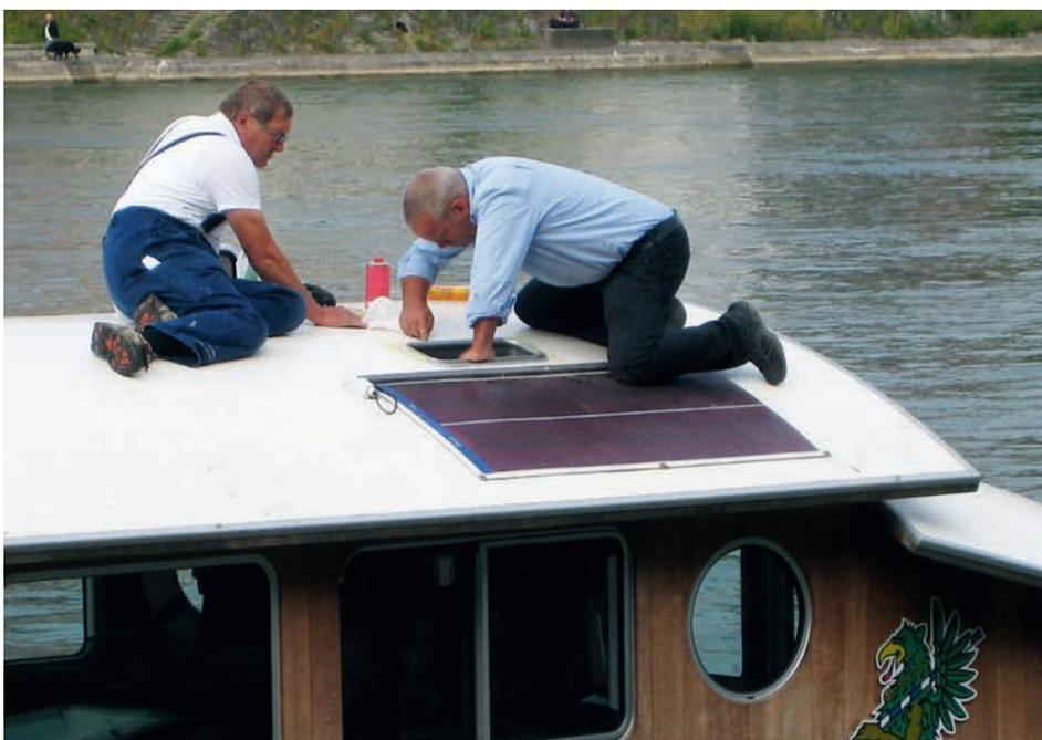
Das am 13. Februar von einer Sturmböe abgerissene Solarpaneel wurde professionell repariert und wieder sachgemäss auf dem Dach der Vogel-Gryff-Fähre befestigt. Zusätzlich wurden die Dachluken nachgedichtet
