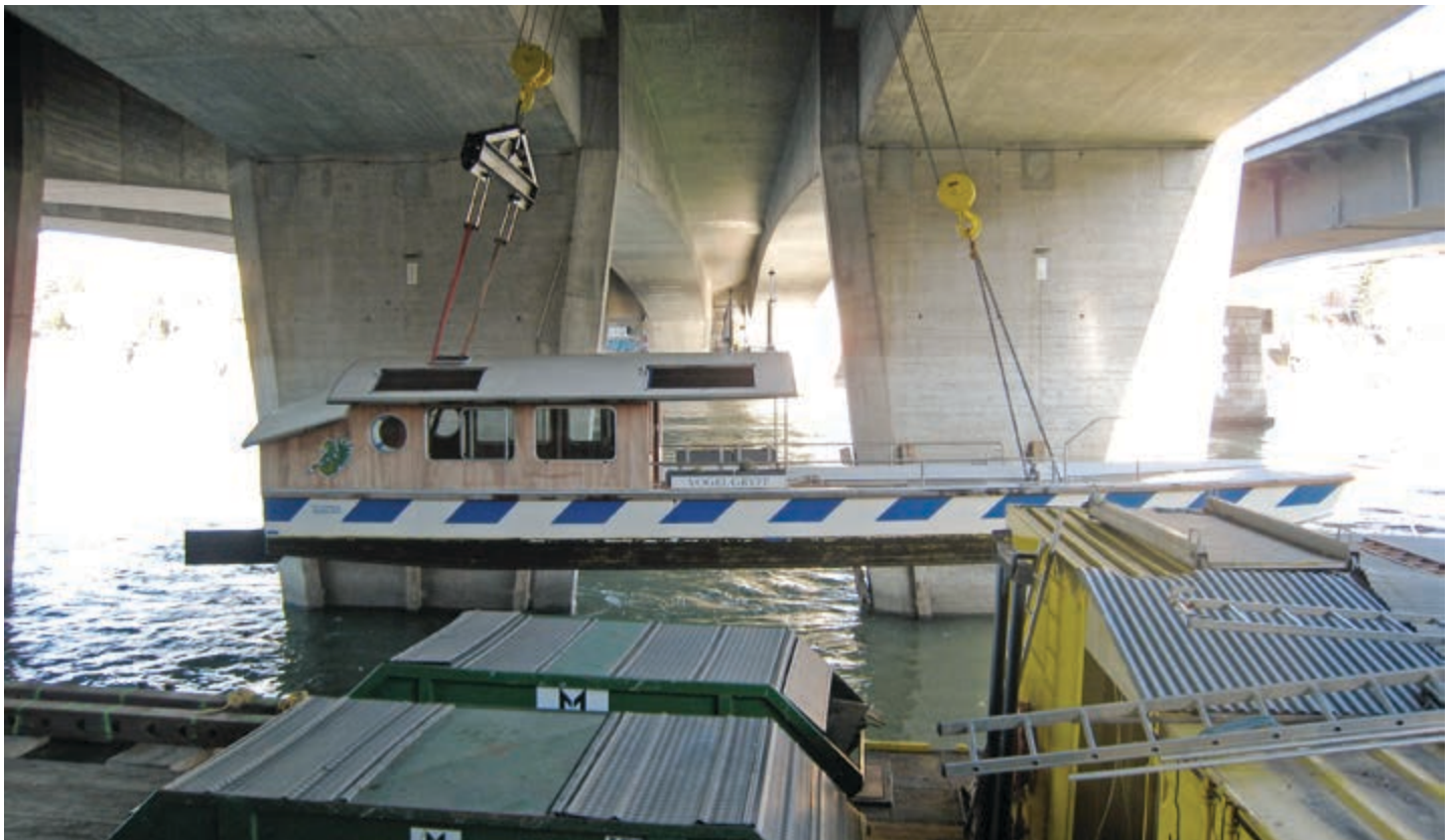
Die Vogel Gryff Fähre wird zur Nachrüstung aus dem Wasser gehoben.
