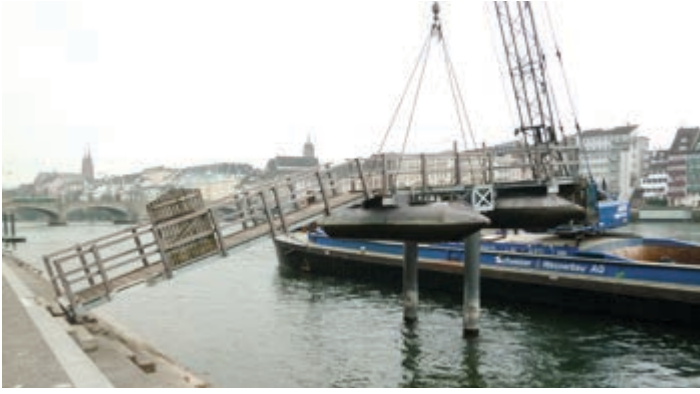
Der Steg im Klingental wurde zur Verbesserung der Hochwassersicherheit umgebaut.
