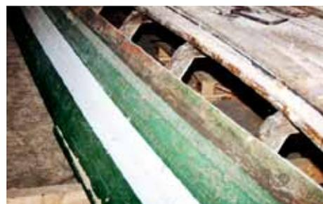
Damit eine Fähre ihre Fahrgäste immer sicher über das Ufer bringen kann, müssen Schäden wie links abgebildet repariert werden. Die Fotos stammen vom alten Langschiff des WFV Horburg, die Holzfähren sind analog gebaut.
